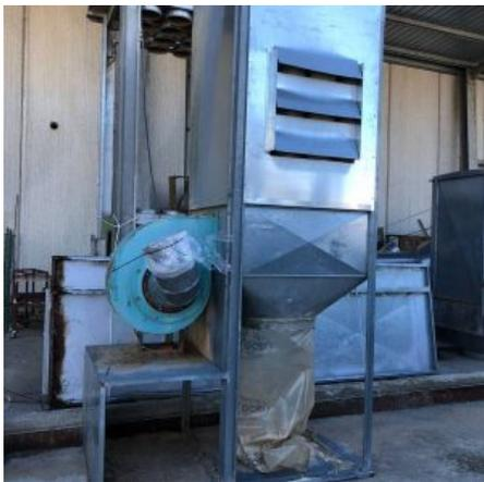
**Descrizione:** ASPIRATORE MZ TIPO RM 400 AD UN SACCO DIAM. 600 N.16 MANICHE DIAM. 200 MT.1,5 CAD. MOTORE KW3
