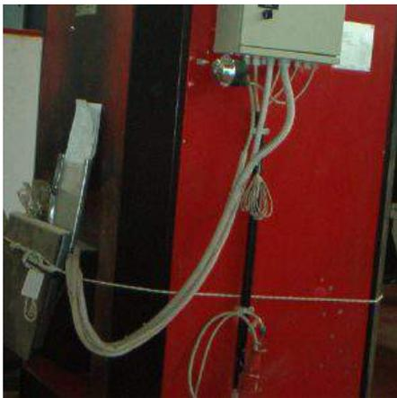
**Descrizione:** CALDAIA COMAFER TURBOMATIC MOD. T150 - pressione d'esercizio 2 kg./cm2 - temperatura 90° c - capacità lt.400 - potenza focolare 200.000 k/cal/h - potenza al nominale 150.000 k/cal/h + alimentatore con coclea: \*altezza utile mm. 900 \*diam. interno mm.1000 \*lunghezza coclea mm. 600 \*diam. coclea mm. 120 + mini silos
